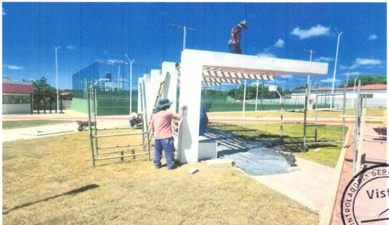
FOTO 36 – APLICAÇÃO E LIXAMENTO DE MASSA LÁTEX EM PAREDES, UMA DEMÃO
