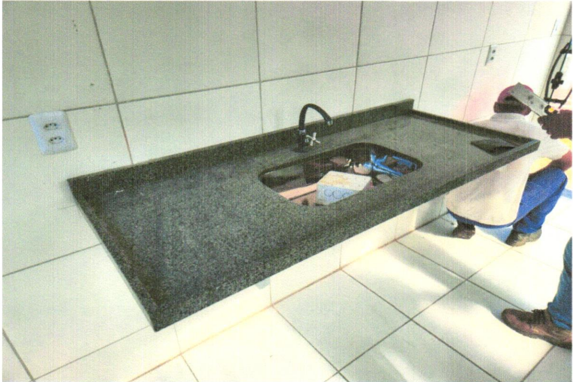
FOTO 07 - BANCADA GRANITO CINZA 150 X 60 CM, COM CUBA DE INOX
