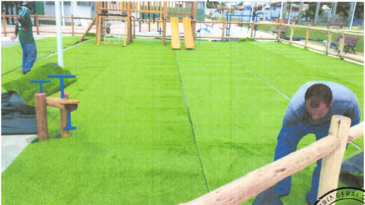
FOTO 68 – FORNECIMENTO E INSTALAÇÃO DA GRAMA SINTÉTICA
