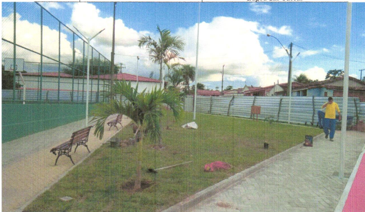
FOTO 63 – FORNECIMENTO E PLANTIO DE PALMEIRA
