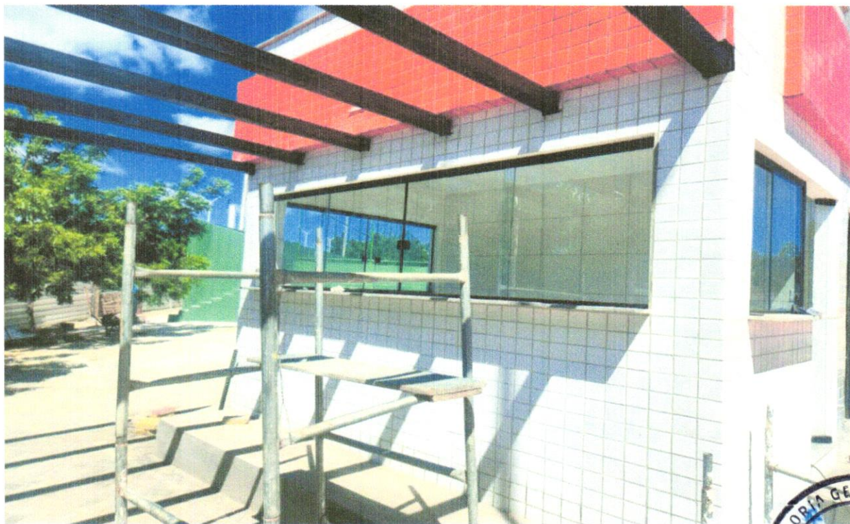
FOTO 10 – FORNECIMENTO E INSTALAÇÃO DE ESQUADRIAS
