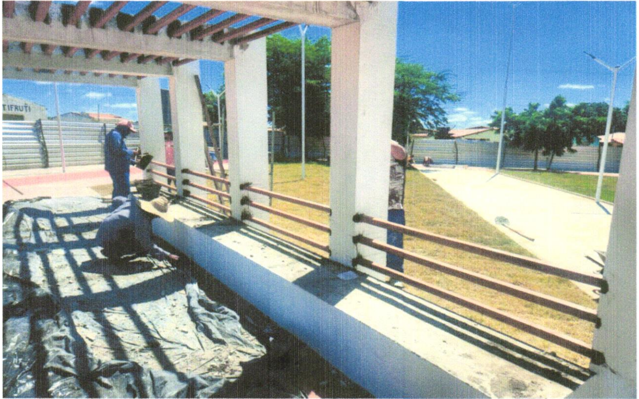
FOTO 35 – ALVENARIA DE BLOCOS DE CONCRETO ESTRUTURAL 14X19X29 CM
