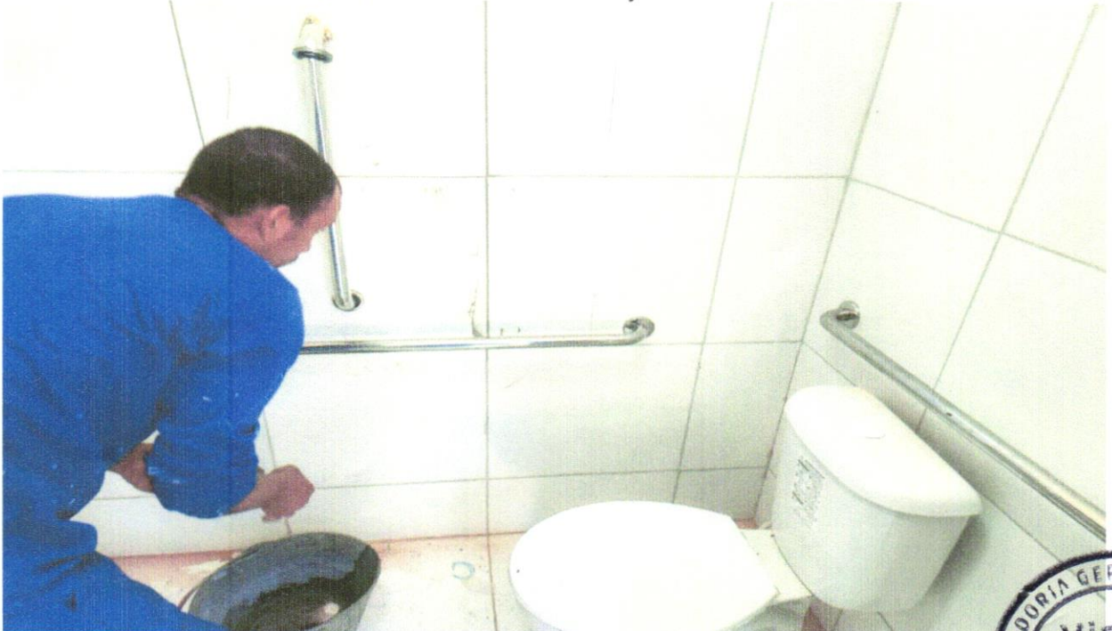
FOTO 54 – FORNECIMENTO E INSTALAÇÃO DE BARRAS DE APOIO
