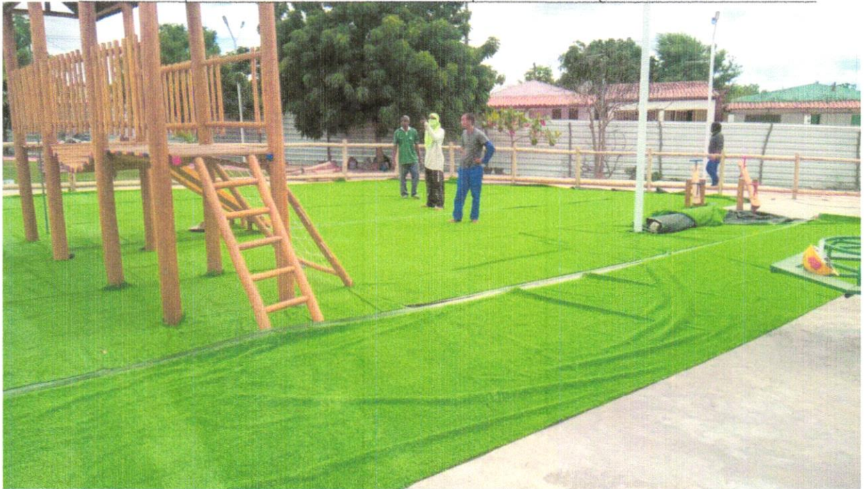
FOTO 71 – FORNECIMENTO E INSTALAÇÃO DA GRAMA SINTÉTICA
