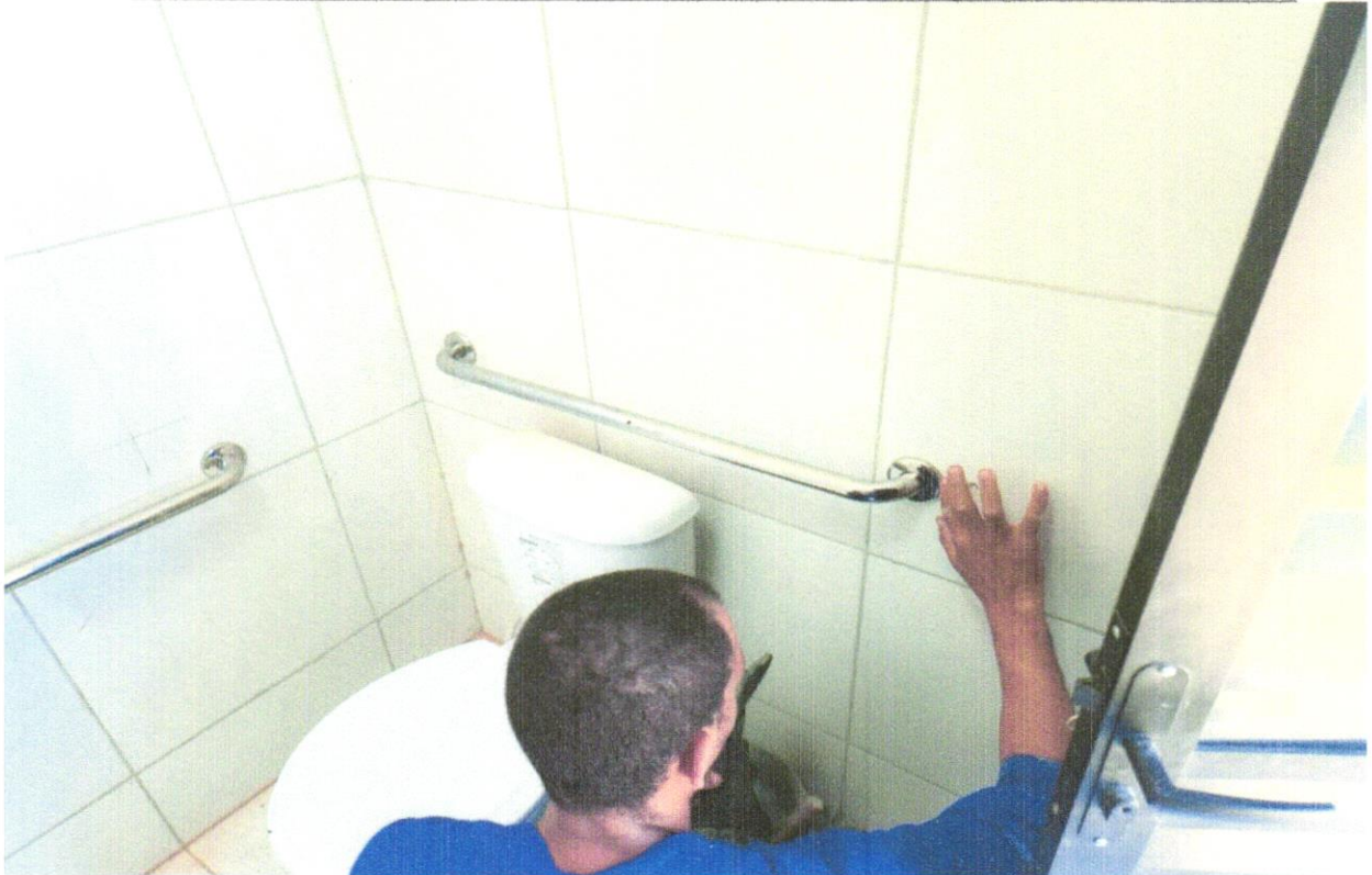
FOTO 53 – FORNECIMENTO E INSTALAÇÃO DE BARRAS DE APOIO
