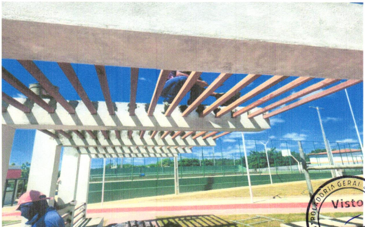
FOTO 34 – MADEIRAMENTO EM MASSARANDUBA/MADEIRA DE LEI, SERRADA 5 CM X 5 CM
