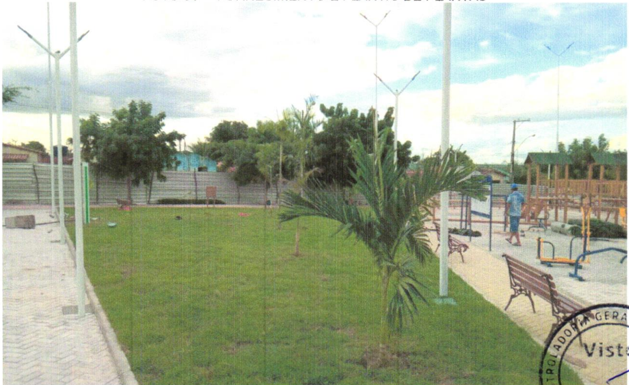
FOTO 62 – FORNECIMENTO E PLANTIO DE PALMEIRA
