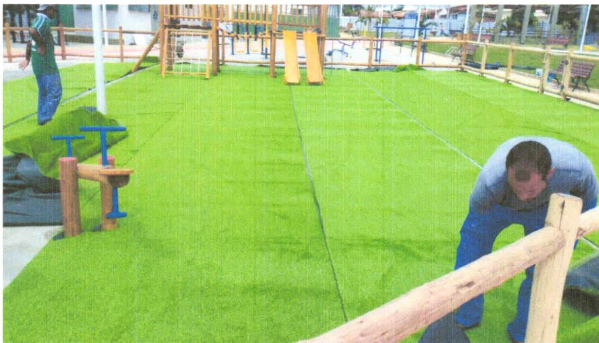
FOTO 69 – FORNECIMENTO E INSTALAÇÃO DA GRAMA SINTÉTICA
