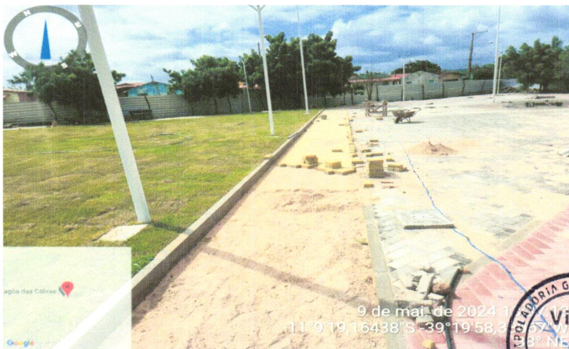
FOTO 18 – EXECUÇÃO DE PÁTIO/ESTACIONAMENTO EM PISO INTERTRAVADO
