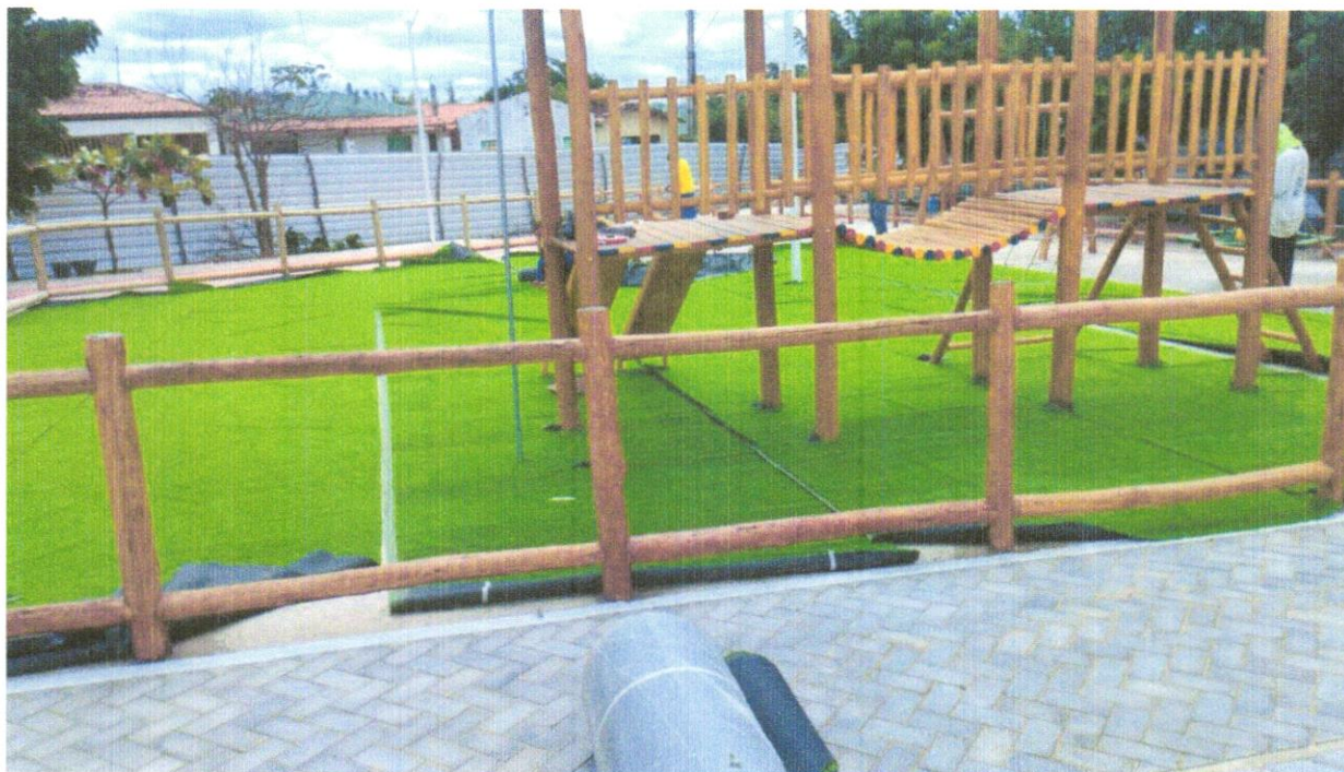
FOTO 65 – FORNECIMENTO E INSTALAÇÃO DA GRAMA SINTÉTICA
