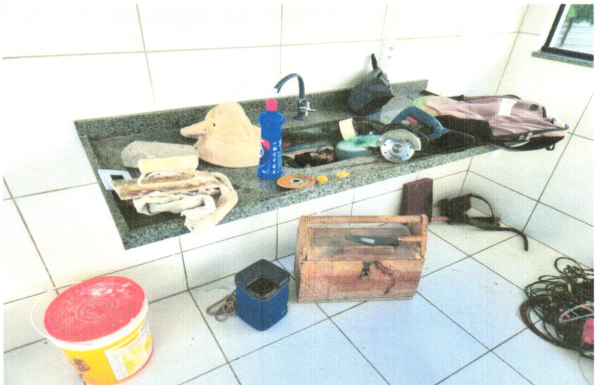
FOTO 06 - BANCADA GRANITO CINZA 150 X 60 CM, COM CUBA DE EMBUTIR DE INOX
