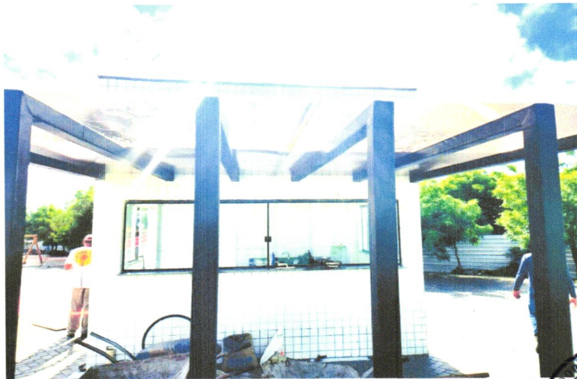
FOTO 14 – FORNECIMENTO E INSTALAÇÃO DE CHAPAS DE POLICARBONATO
