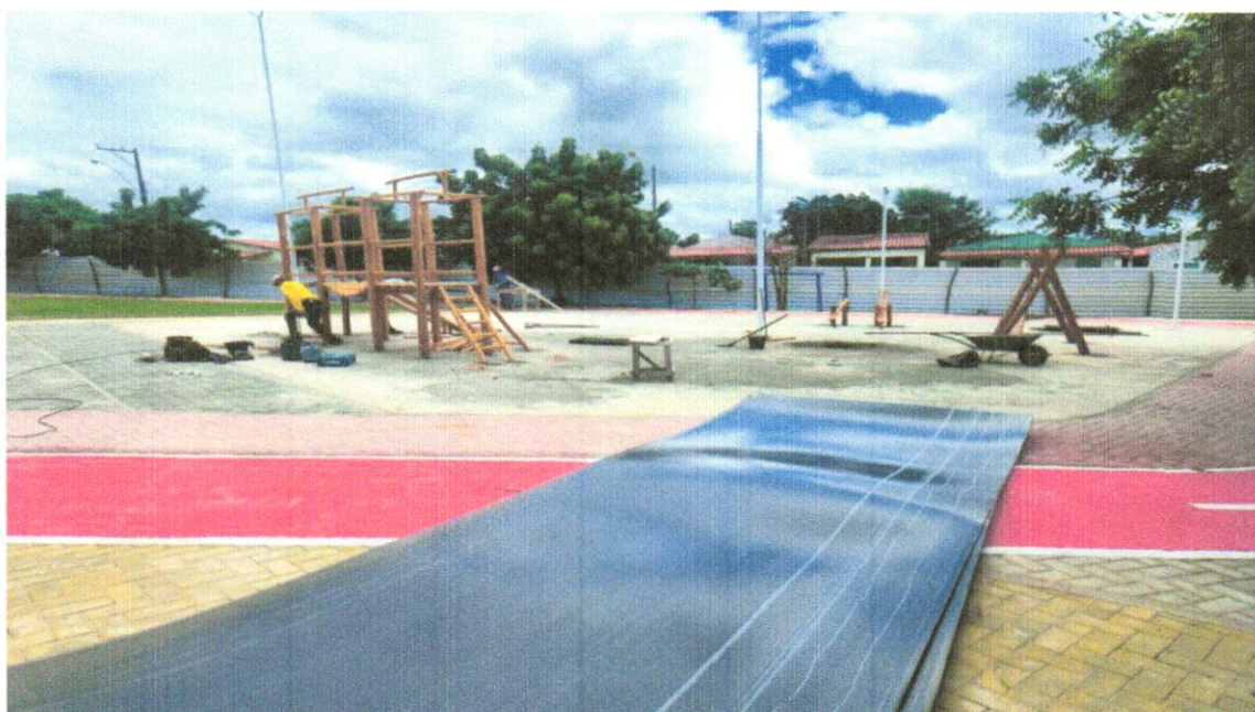
FOTO 12 – FORNECIMENTO E INSTALAÇÃO DE BRINQUEDOS
