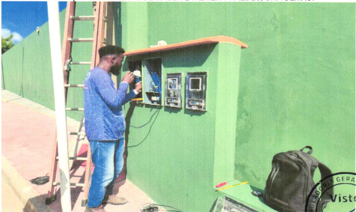
FOTO 50 – INSTALAÇÃO DO PADRÃO DE ENERGIA
