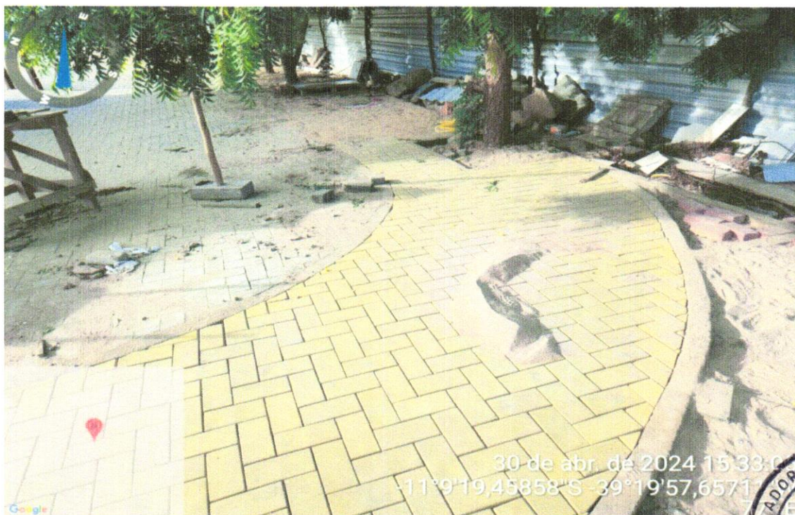
FOTO 16 – EXECUÇÃO DE PÁTIO/ESTACIONAMENTO EM PISO INTERTRAVADO
