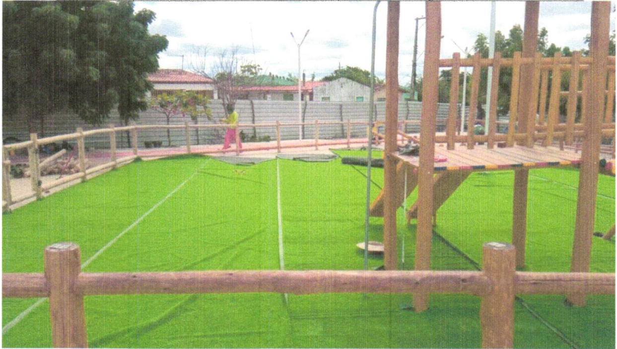
FOTO 67 – FORNECIMENTO E INSTALAÇÃO DA GRAMA SINTÉTICA
