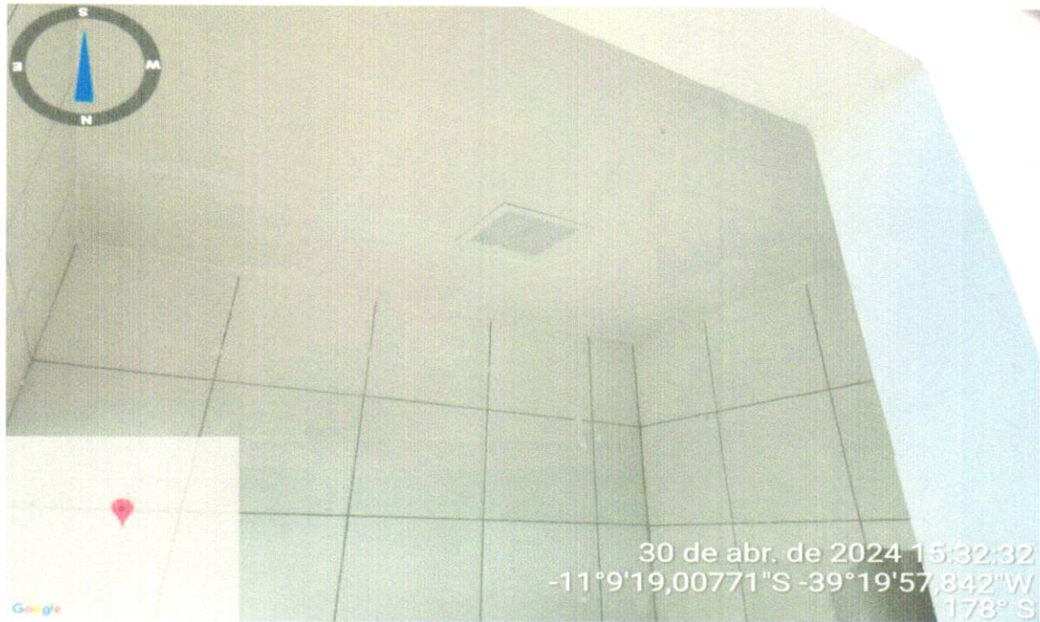
FOTO 03 – FORNECIMENTO E INSTALAÇÃO DE LUMINÁRIAS
