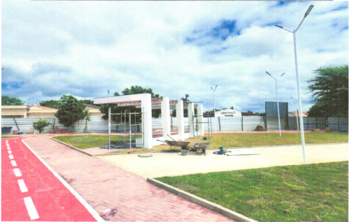
FOTO 49 – APLICAÇÃO E LIXAMENTO DE MASSA LÁTEX EM PAREDES, UMA DEMÃO.
