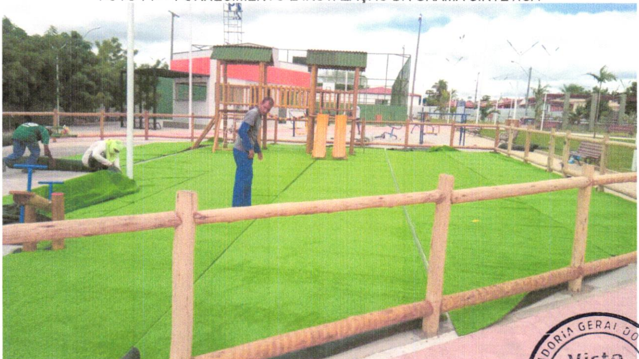
FOTO 72 – FORNECIMENTO E INSTALAÇÃO DA GRAMA SINTÉTICA
