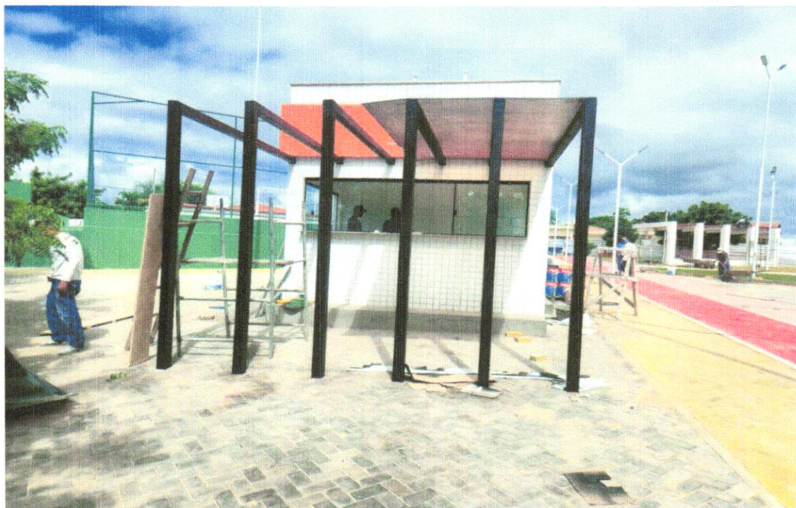
FOTO 13 – FORNECIMENTO E INSTALAÇÃO DE CHAPAS DE POLICARBONATO
