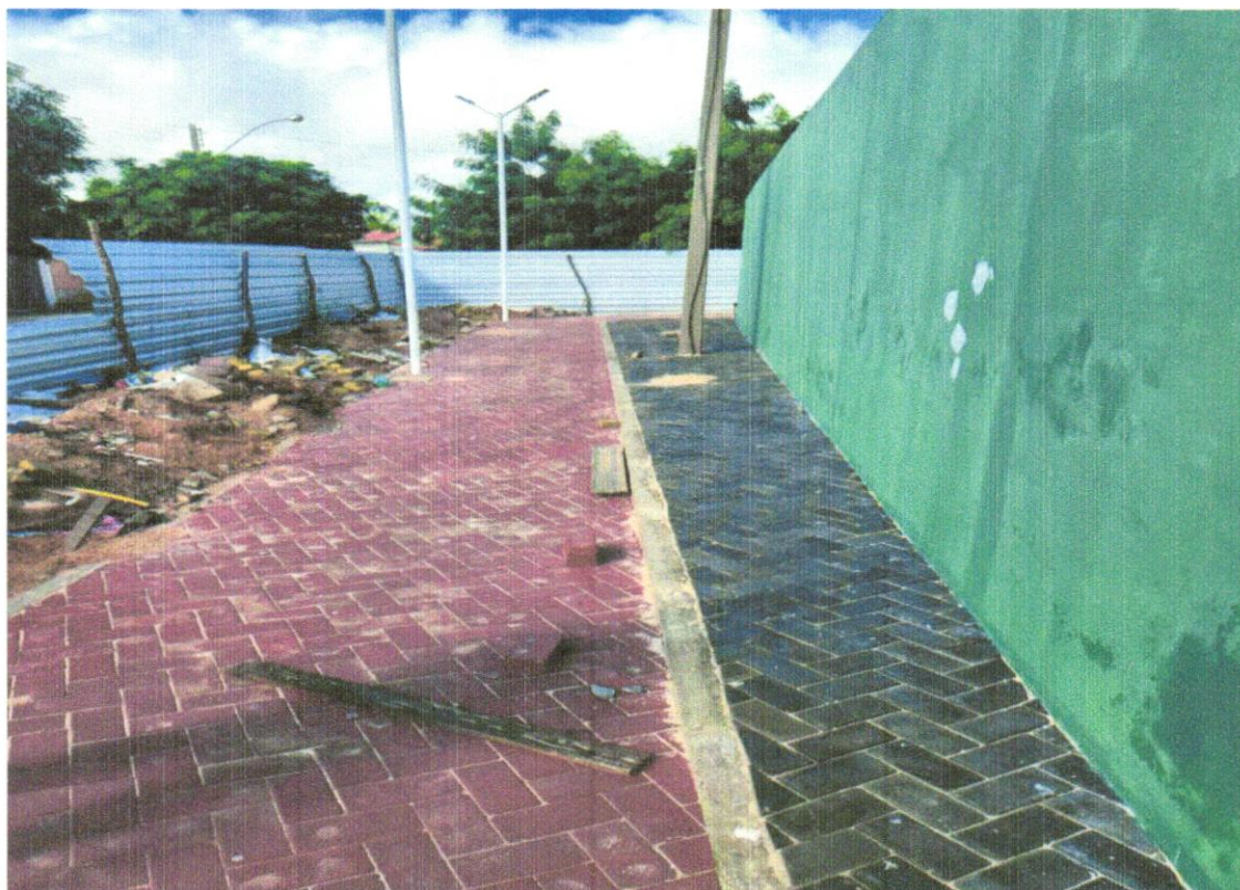
FOTO 19 – EXECUÇÃO DE PINTURA DA PAREDE DA ARQUIBANCADA
