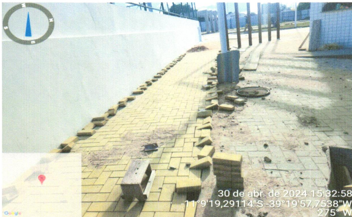
FOTO 17 – EXECUÇÃO DE PÁTIO/ESTACIONAMENTO EM PISO INTERTRAVADO
