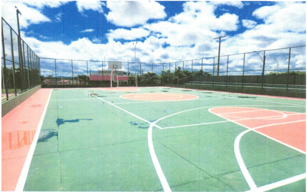
FOTO 25 – PINTURA ACRÍLICA DE FAIXAS DE DEMARCAÇÃO EM QUADRA POLIESPORTIVA
