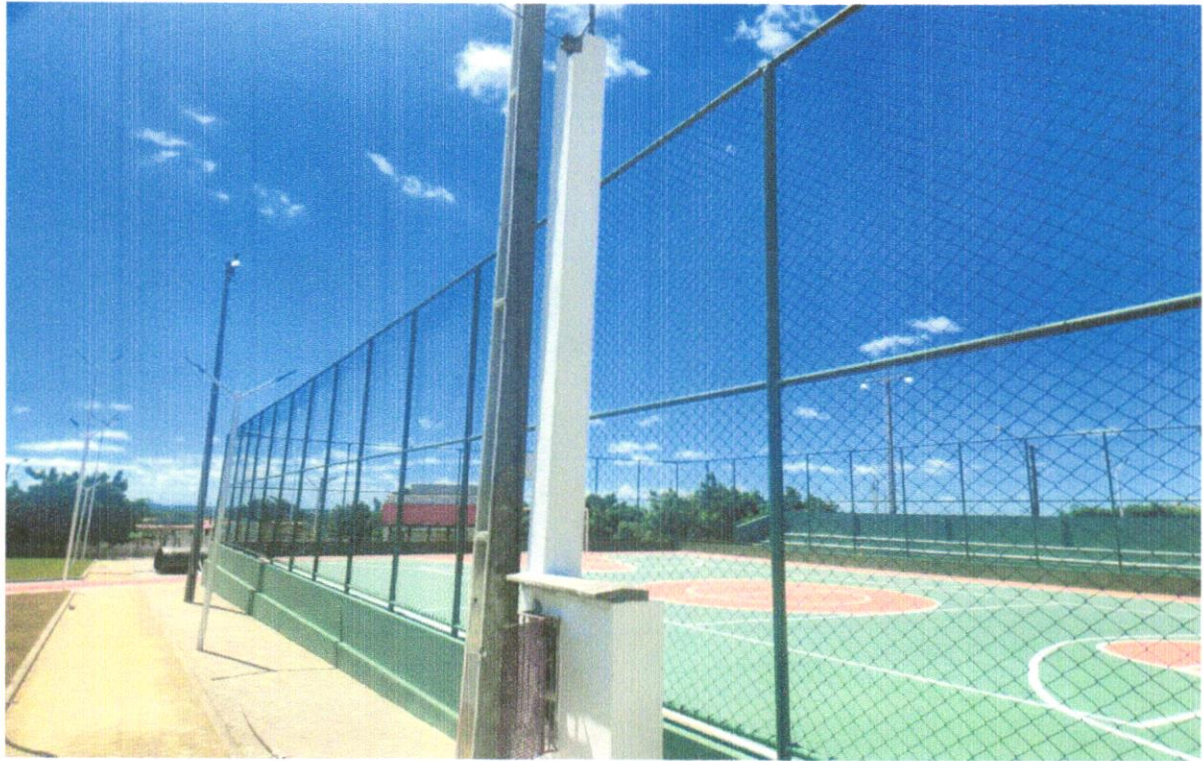
FOTO 39 – EMASSAMENTO E LIXAMENTO DO POSTE
