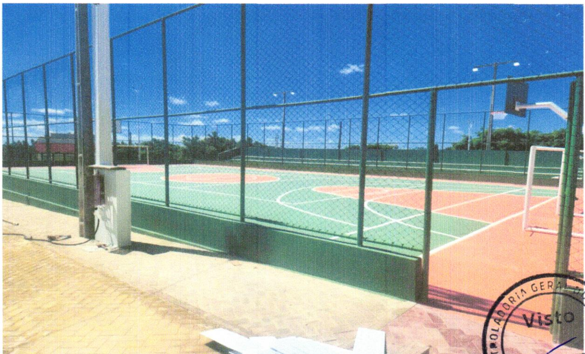
FOTO 38 – INSTALAÇÃO DAS LUMINÁRIAS
