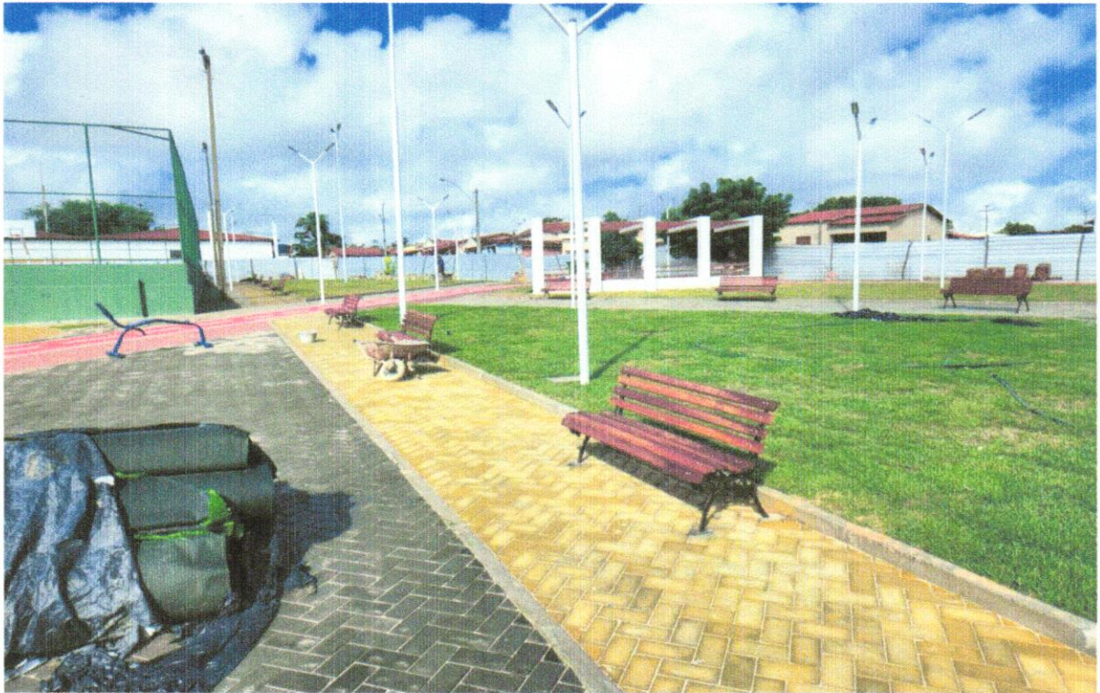
FOTO 37 – FORNECIMENTO E INSTALAÇÃO DE BANCO DE MADEIRA
